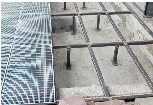
Рис. 20 – Процесс монтажа первой ступени очистки.
